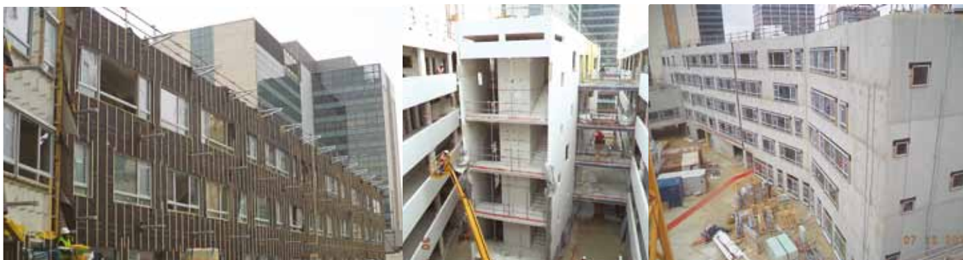
Le chantier du lycée Lucie Aubrac début décembre 2017
